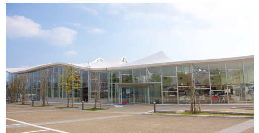
<江ノ島ヨットハーバー内クラブハウス>
